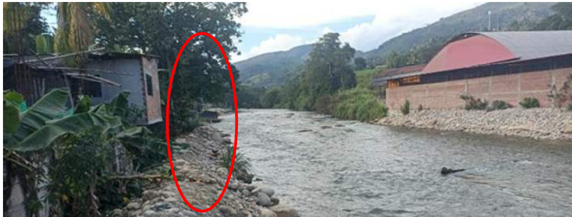
FIGURA N° 01: SE OBSERVA LA EROSION DEL TALUD DE LA MARGEN IZQUIERDA.
