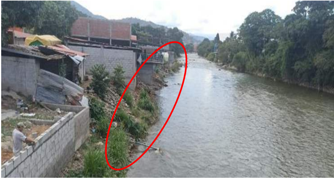
FIGURA N° 01: SE OBSERVA LA EROSION DEL TALUD DE LA MARGEN IZQUIERDA.
